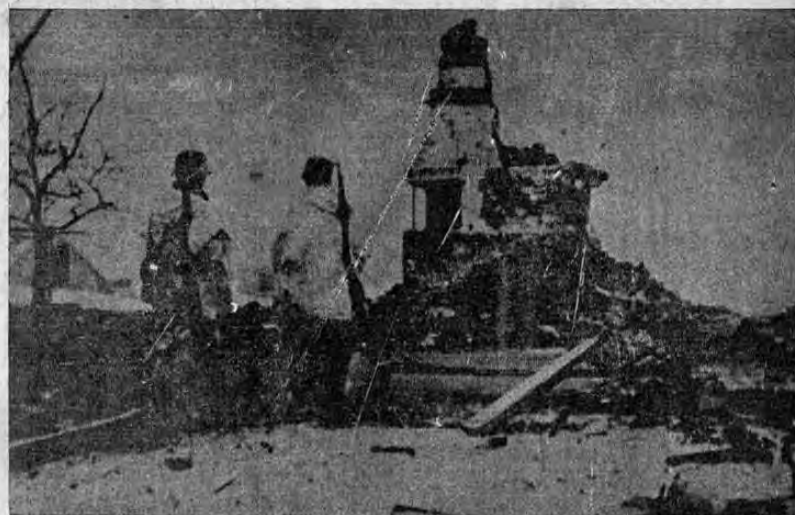
FINLANDIA.—Esta fotografía fué tomada hace un mes en la ciudad finlandesa de Viipuri (Viiborg) situada a pocos kilómetros de la frontera con Rusia en la región de la Karelia. Se muestra en ella el estado en que importantes edificaciones después de que los aviones y las granadas de acción comercial y de viviendas han quedado los rusos han llovido sobre la ciudad. Desde entonces a hoy, según los despachos cablegráficos, la ofensiva se ha intensificado y sobre la ciudad martir han llovido las bombas en mayor profusión. Al pie de este monumento que señala con elocuencia muda y penetrante la obra de la agresión roja contra una república democrática y liberal, dos defensores de Finlandia montan su centinela y miran el horizonte en donde están sus hermanos luchando gallardamente por conservar para su pueblo el suelo que codician los invasores.
